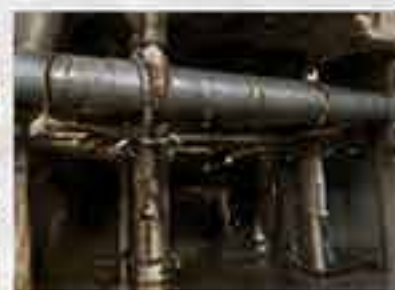
配管・ダクト周辺
