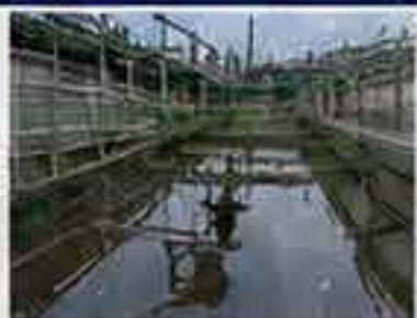
排水処理設備
